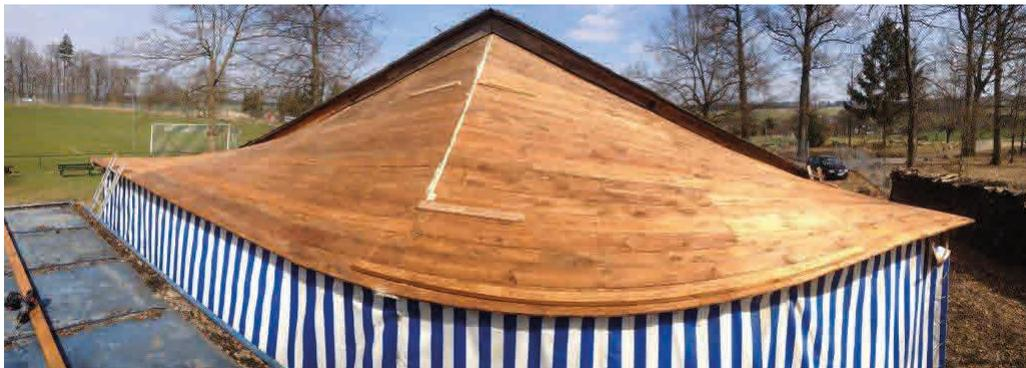
Das Dach der Festzelt-Bühne ist undicht und wird ebenfalls 2014 in Eigenregie komplett erneuert. Gleichzeitig werden weitere Ausbesserungsarbeiten am Dach durchgeführt.
